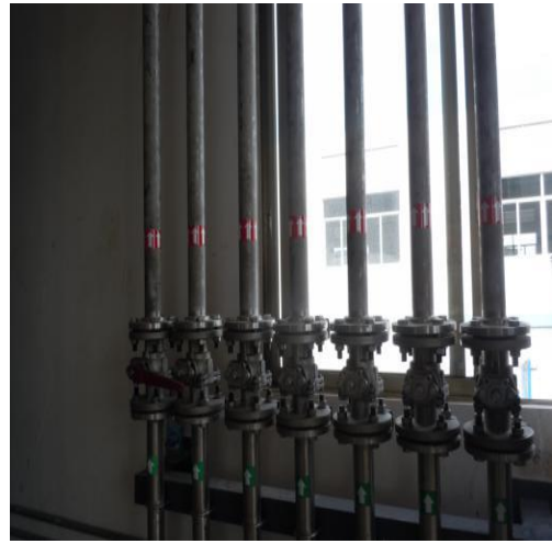
图 1 甲类车间 5 管道流向标识整改前后照片
