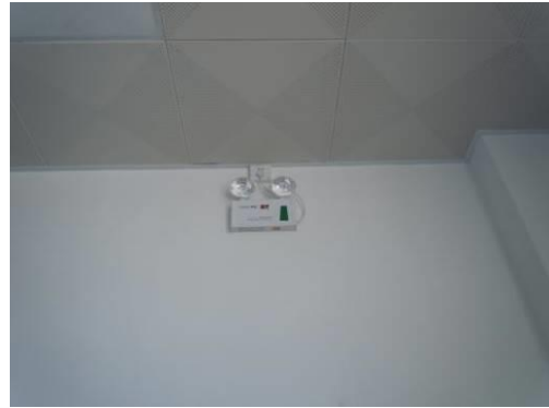
图 2 甲类车间 5 中控室应急照明装置整改前后照片
