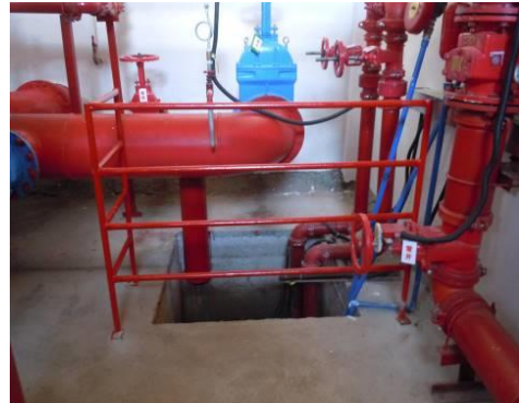
图 3 消防水泵房内消防水坑整改前后照片
