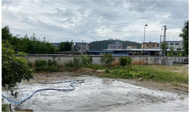
东面木材厂及架空电力线
