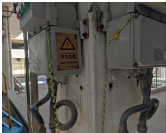
整改 4: 电气接线冗余口已采用防火材料密封
