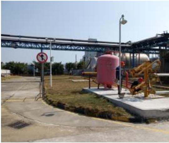
丁二烯罐组万向管道卸车系统、泡沫罐
