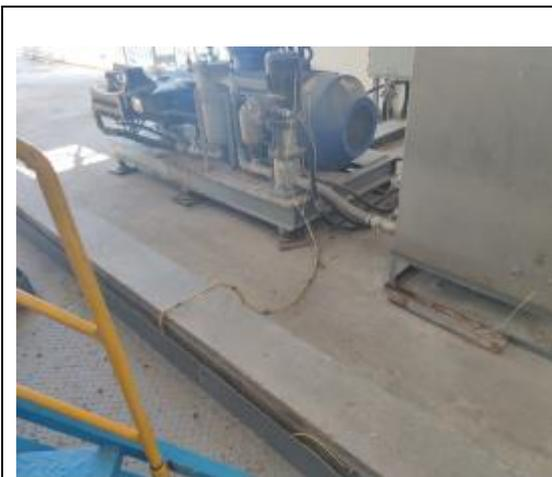
整改 5: 电机漏电保护与接地体连接
