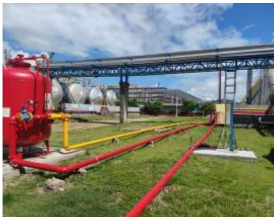
整改 7: 泡沫罐距离储罐 20m
