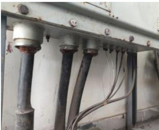
整改 3: 接线余口已采用防火材料封堵
