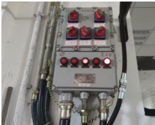
整改 6: 照明线路螺纹密封连接
