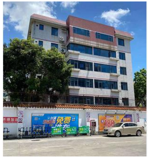
东面倚天苑住宅小区
