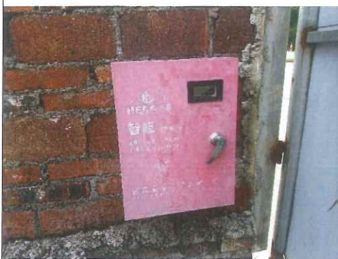
静电接地仪及静电消除器
