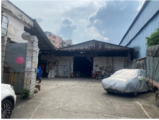
西南面废品回收厂房
