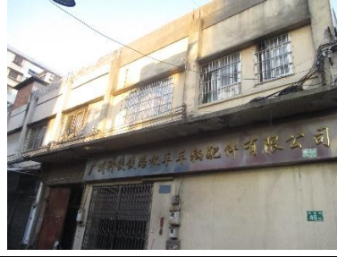
北面二层建筑
