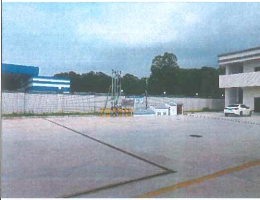
卸油区与通气管
