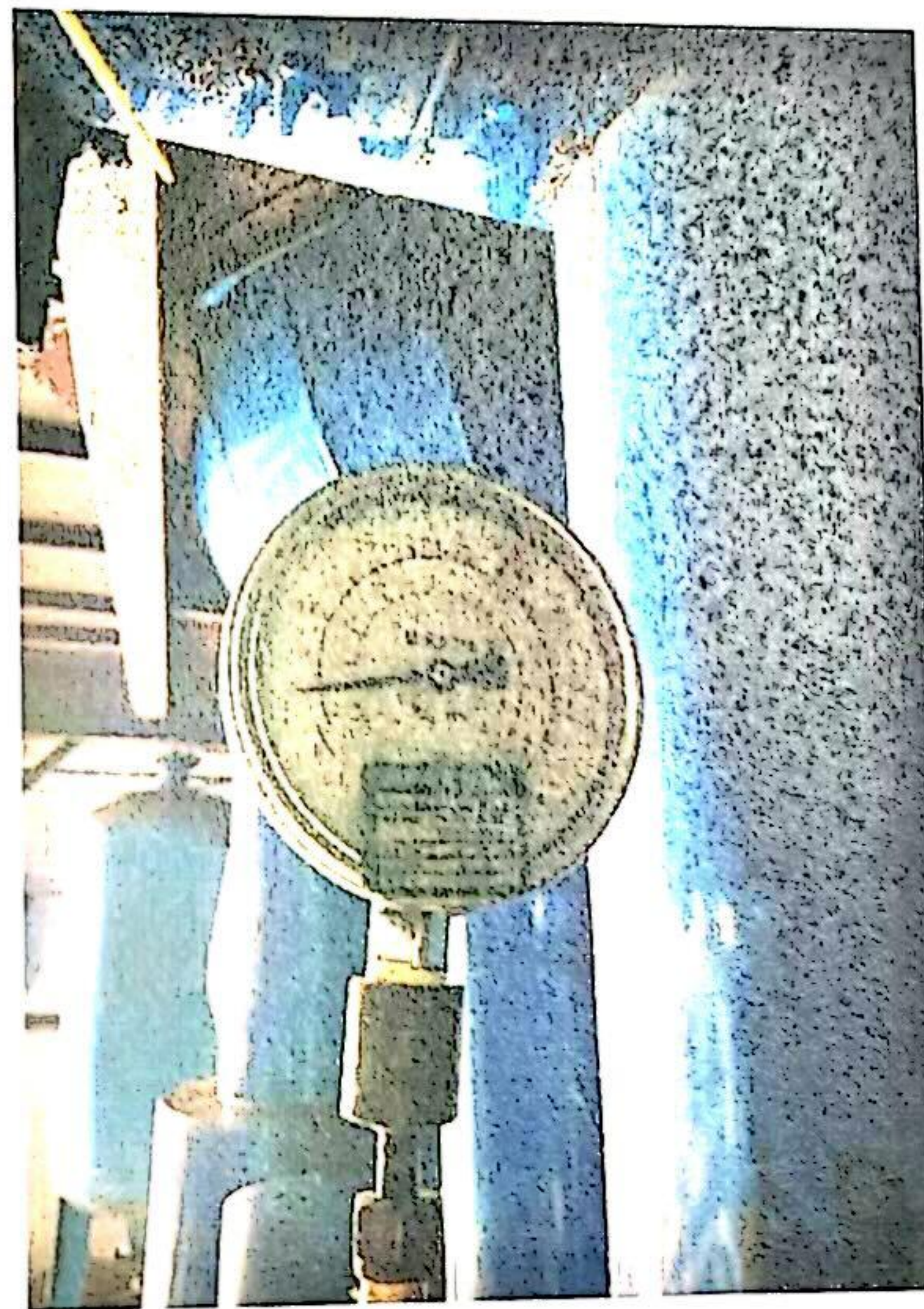
压力表工艺红线已标示
