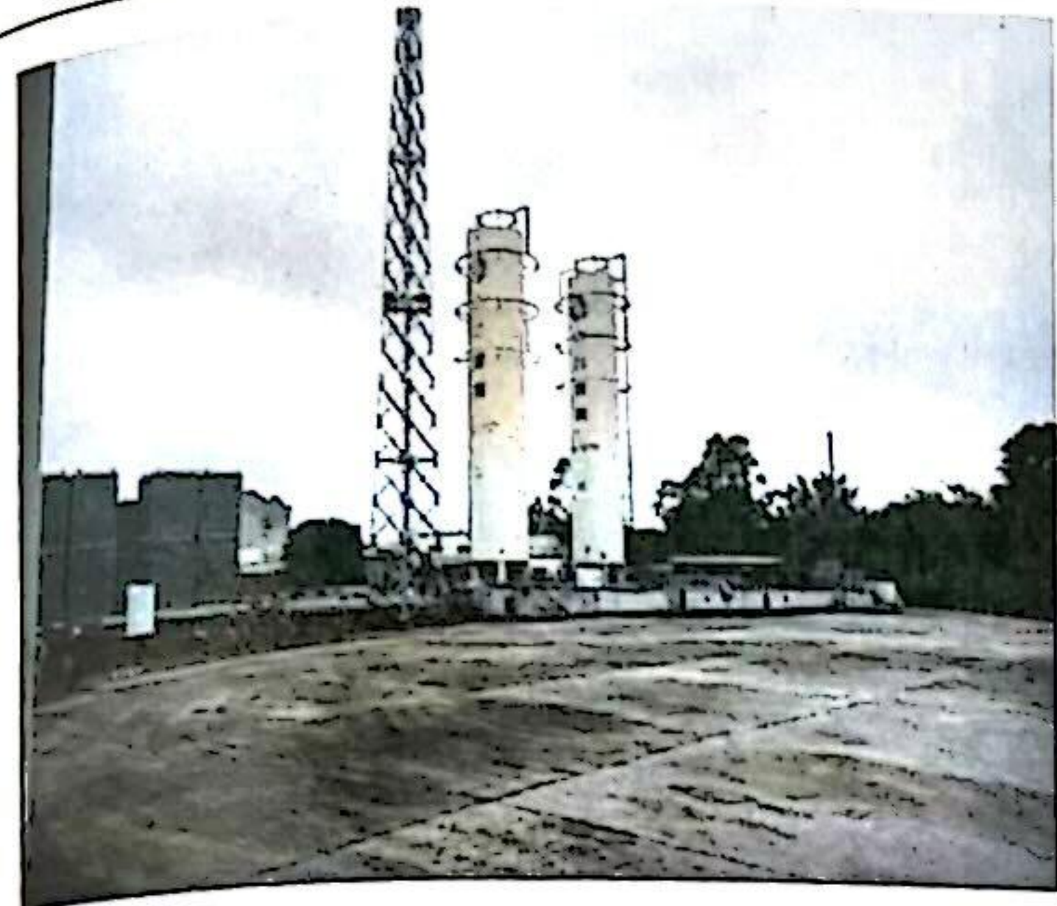
气化站储罐区
