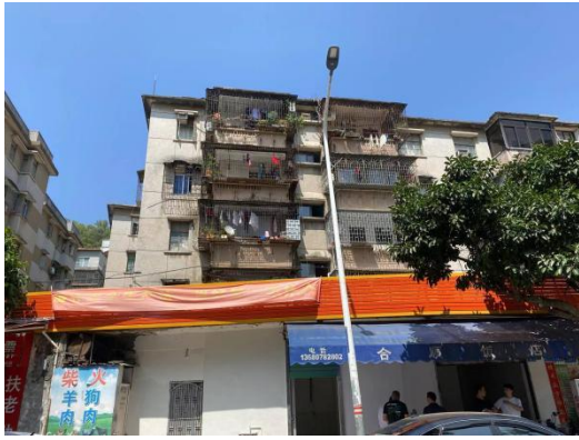
北面 5 层居民楼
