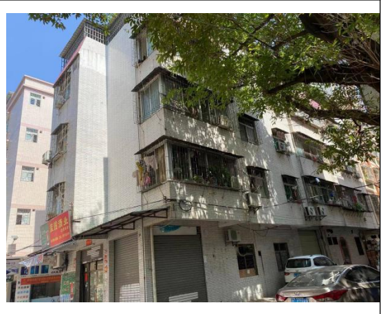
北面 5 层居民楼
