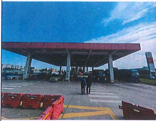
加油区、储罐区
