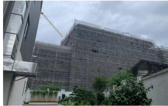
宿舍楼北侧在建厂房
