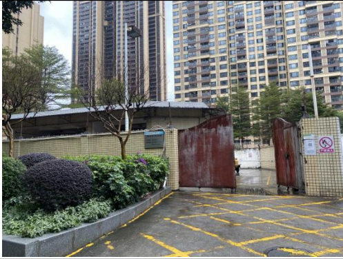
同济东供应站外观
