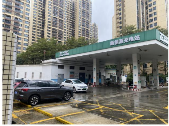
东面新能源站
