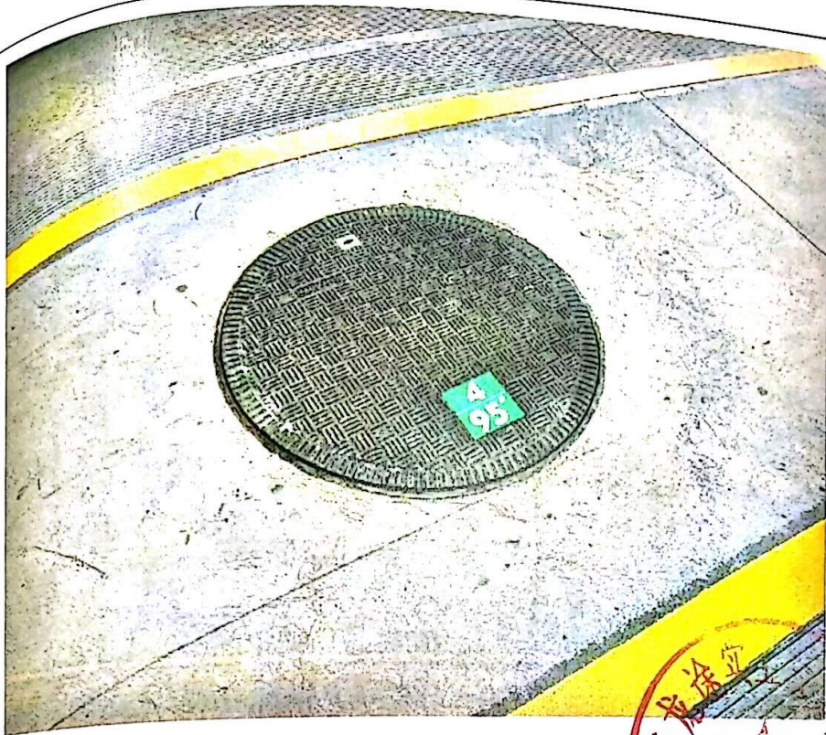
加油站油罐区照片
