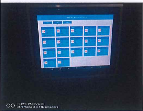
油罐在线渗漏监测系统
