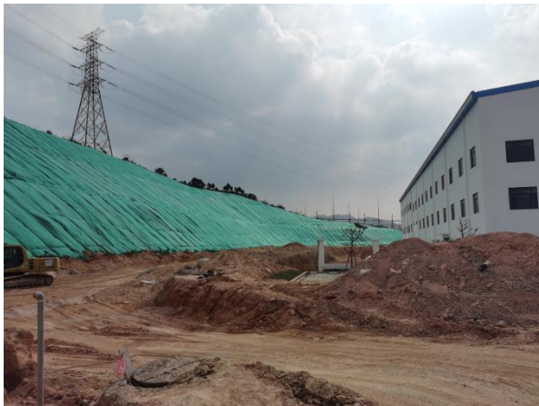
厂区东面环山路（在建）
