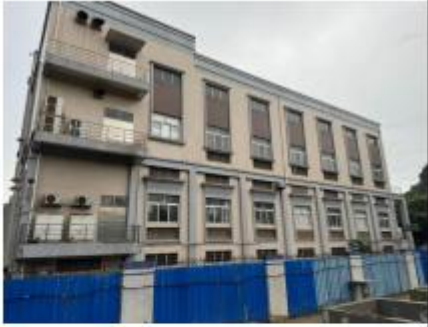
东北侧-广船国际 110kV 变配电站
