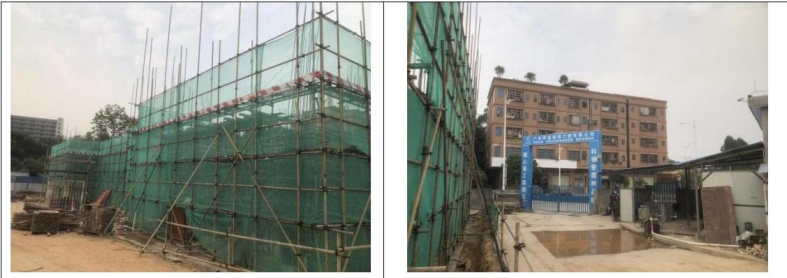
北侧二期用地在建的设备及服务设施用房
