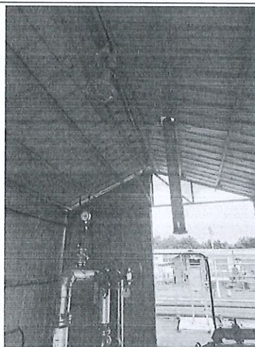
丁二烯进料管道切断情况
