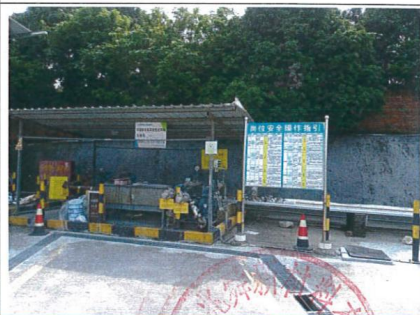
E3 储罐区卸车区
