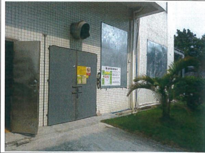
A1 乙类车间临时周转仓
