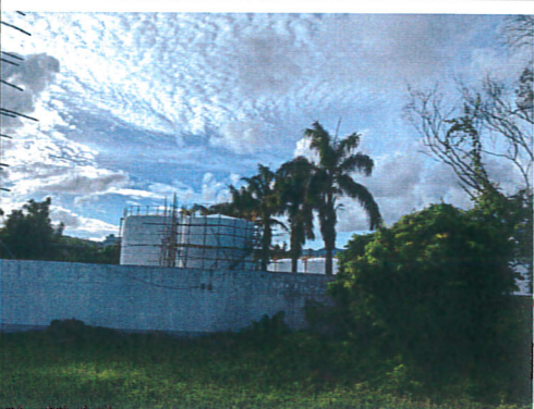
加油站西北侧
