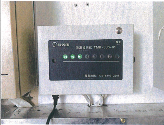
油罐—油管在线渗漏监测系统
