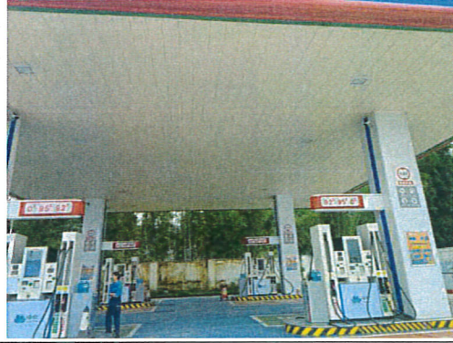
加油区及储罐区
