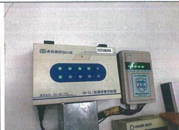
储罐及管道测漏仪
