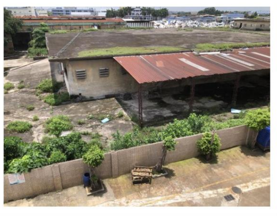
南侧闲置厂区
