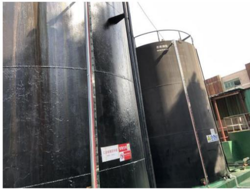
硫酸储罐区
