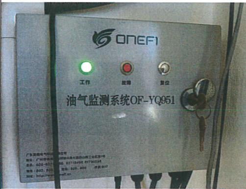
油罐—油管在线渗漏监测系统
