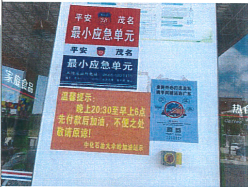
站房外墙紧急按钮
