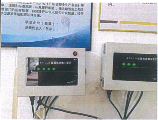
油罐—油管在线渗漏监测系统
