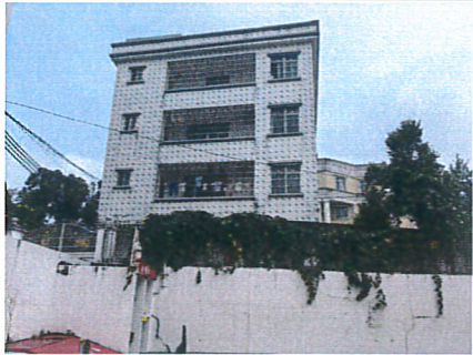
加油站西北侧
