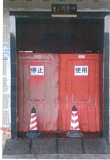
加油站北侧洗手间停用
