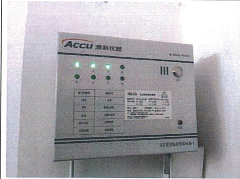
双层罐渗漏监测系统
