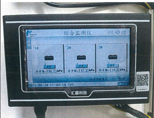
双层油罐在线渗漏监测系统
