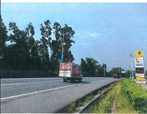
加油站西北侧
